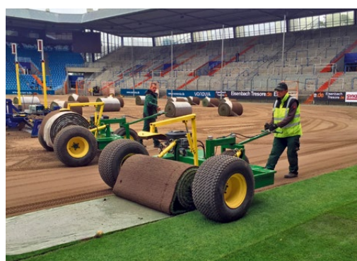
Verlegen der Dicksode (Foto: O. Schneider)
