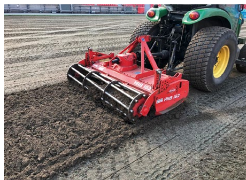
Nivellieren des Planums (Foto: A. Pfeiffer)
