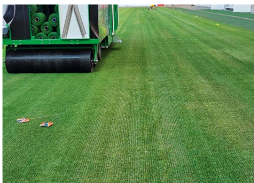
Stitching der Rasenfläche (Foto: F. Riesterer / VfB Stuttgart)
